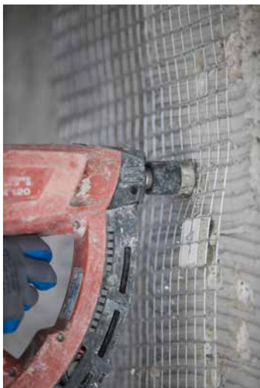
Fig. 22 - Fixação da FACHAFORTE® com pistola fincapino
