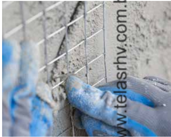
Fig. 31 e 32 - Fixação da tela com os arames
