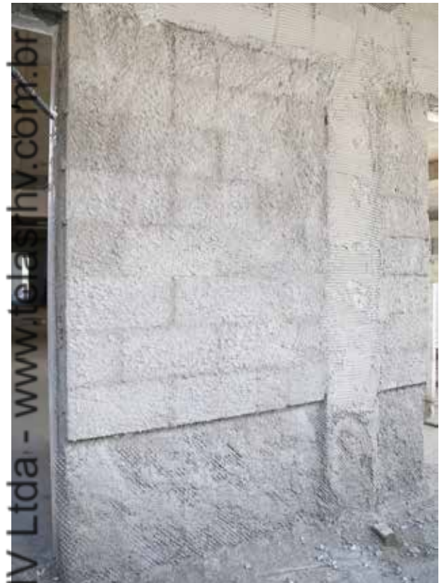
Fig. 11 - Chapisco e alvenaria encunhada
