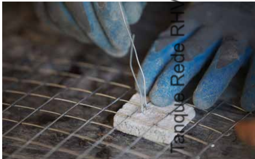
Figura 15 - Posicionamento do espaçador na tela
