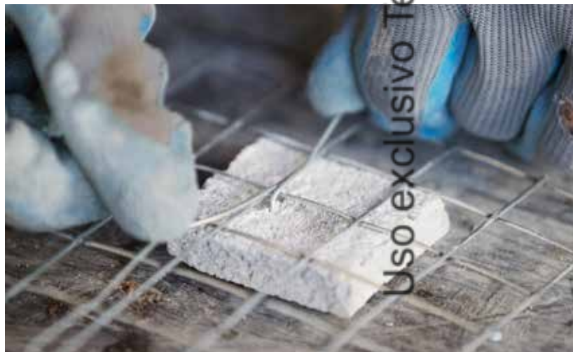
Figura 16 - Fixação do espaçador na tela
