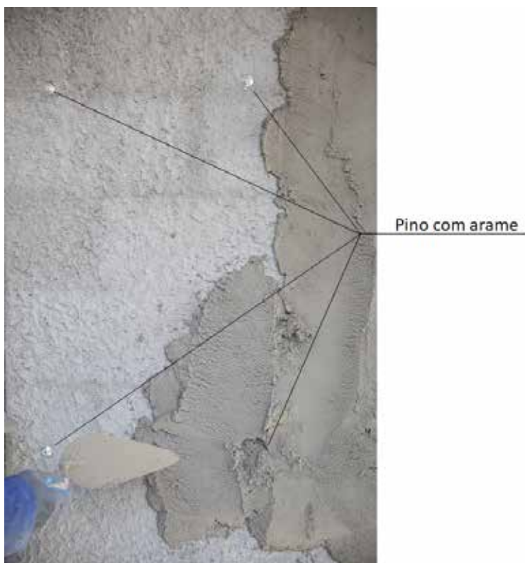
Fig. 27 - Posicionamento dos pinos com arame
