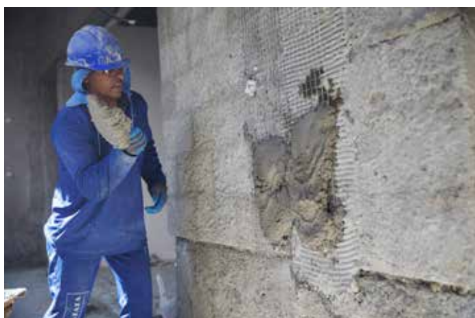
Fig. 24 - Aplicação da argamassa
