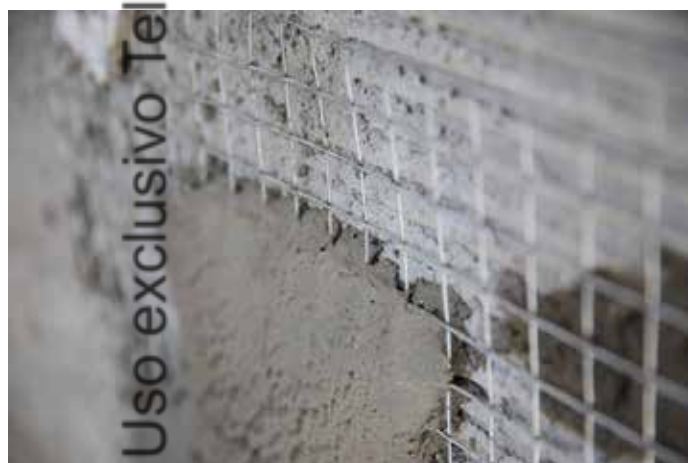
Fig. 25 - Passagem da argamassa através da FACHAFORTE®
